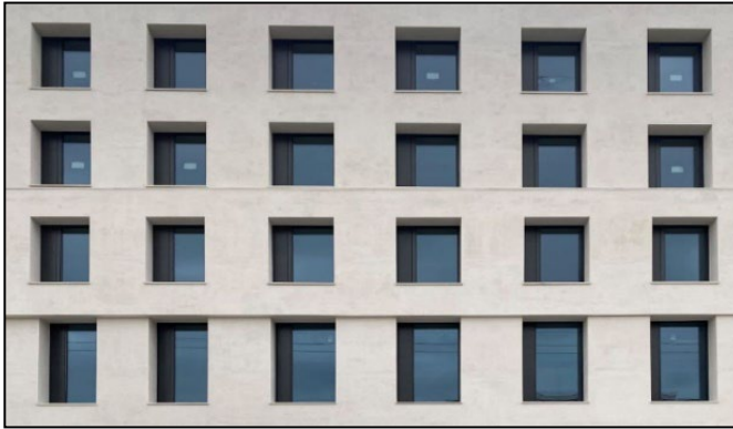
Fig. 2. Object JED Schlieren in Zurich/Switzerland, Architect: Baumschlager Eberle Architekten GmbH, constructor: Bruno Neher Gipsergeschäft GmbH [4]
